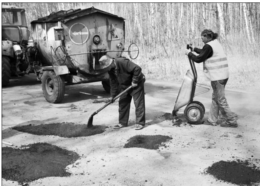
На снимке: ремонт дороги Мосальск-Варшавское шоссе. Фото В. КАСЬЯНОВА.
